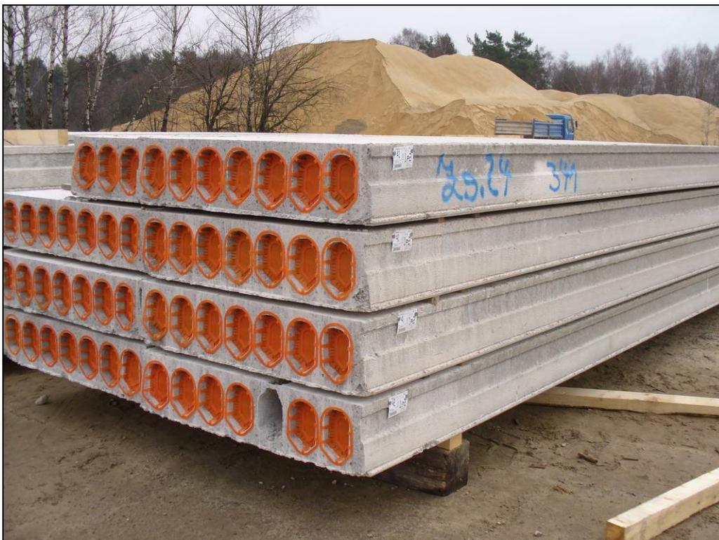
Abbildung 2-4 Elemente einer Spannbeton-Fertigdecke
