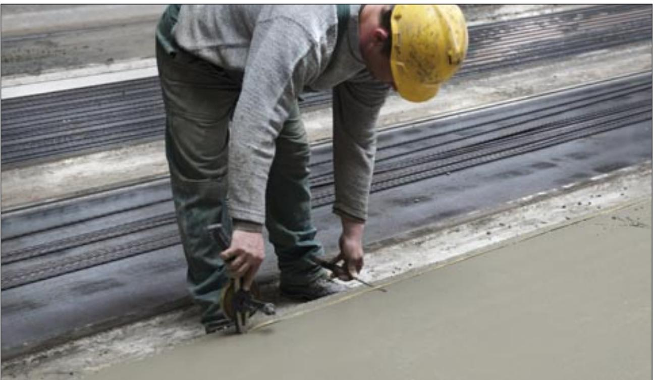
Bild 9: Der Anzeichner markiert Sägeschnitte und Aussparungen
