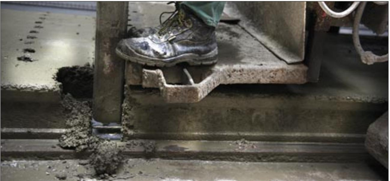
Bild 11: Herstellung einer Aussparung mittels Betonsauger
