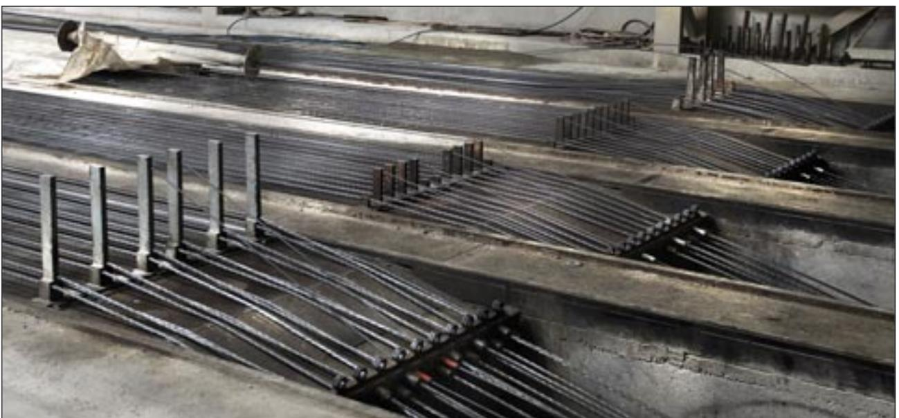
Bild 5: Fertig vorbereitetes Spannmuster in Abhängigkeit der zu betonierenden Querschnittshöhe
