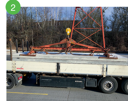
2 Zentriertes Anschlagen mit Hebemittel
