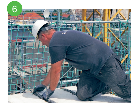
6 Einlegen der Bewehrung vor dem Verguss
