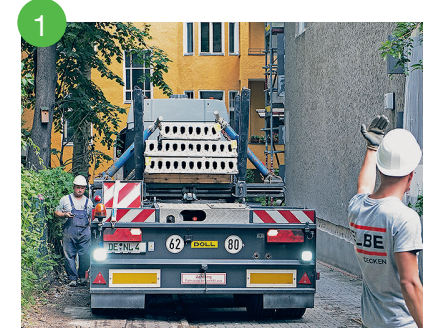
1 Anlieferung auf Baustelle
