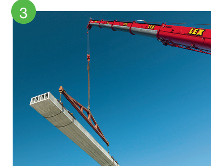
3 Transport mit Kran zum Verlegeort
