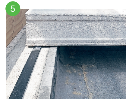
5 Verlegen der Platten auf den Auflagerstreifen (Hartgummi)
