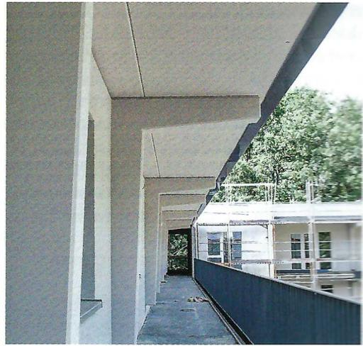
**Bild 4.** Die Spannbetondecken eigneten sich optimal für die Retro-Laubengänge (Foto: © ELBE Decken/Andreas Scherer)
